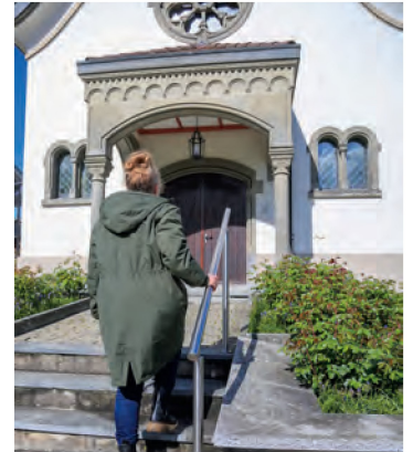
Bei der St. Wendelinskapelle wird der Handlauf bei der Treppe positiv beurteilt, negativ die Stufe zur Eingangstür.
